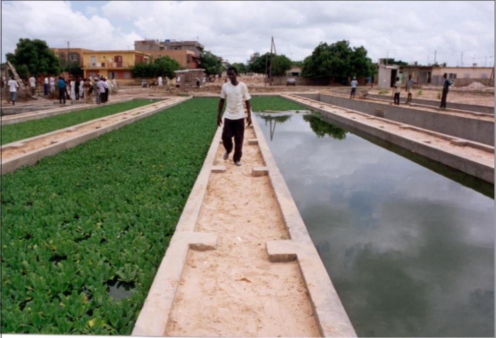
**Photo 31.** Lagunage à laitues d'eau à Castor et à Rufisque
