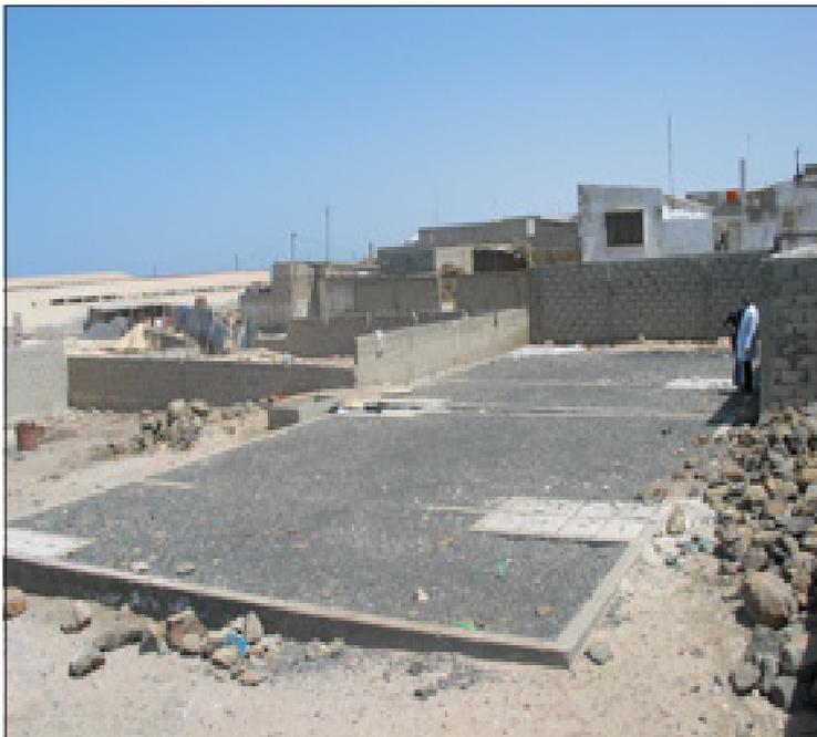
**Photo 33.** Filtre immergé à gravier (basalte)
