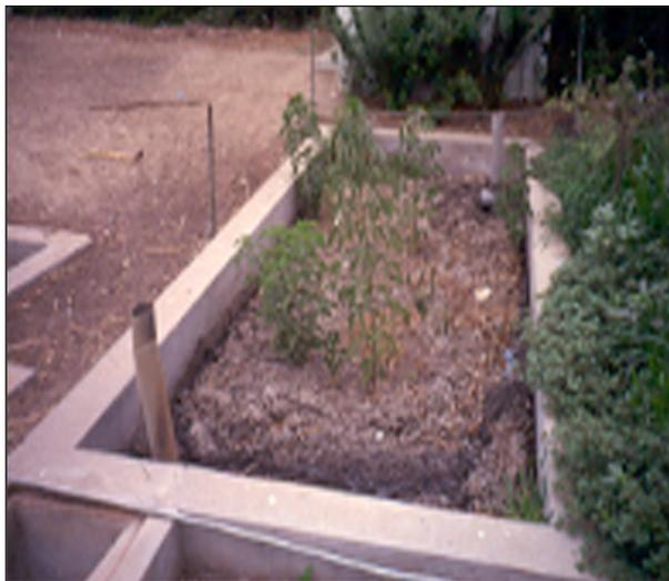
**Photo 30.** Bassin à sédimentation/digestion
