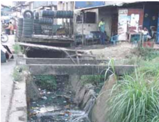
Exutoire des eaux à Douala IV
