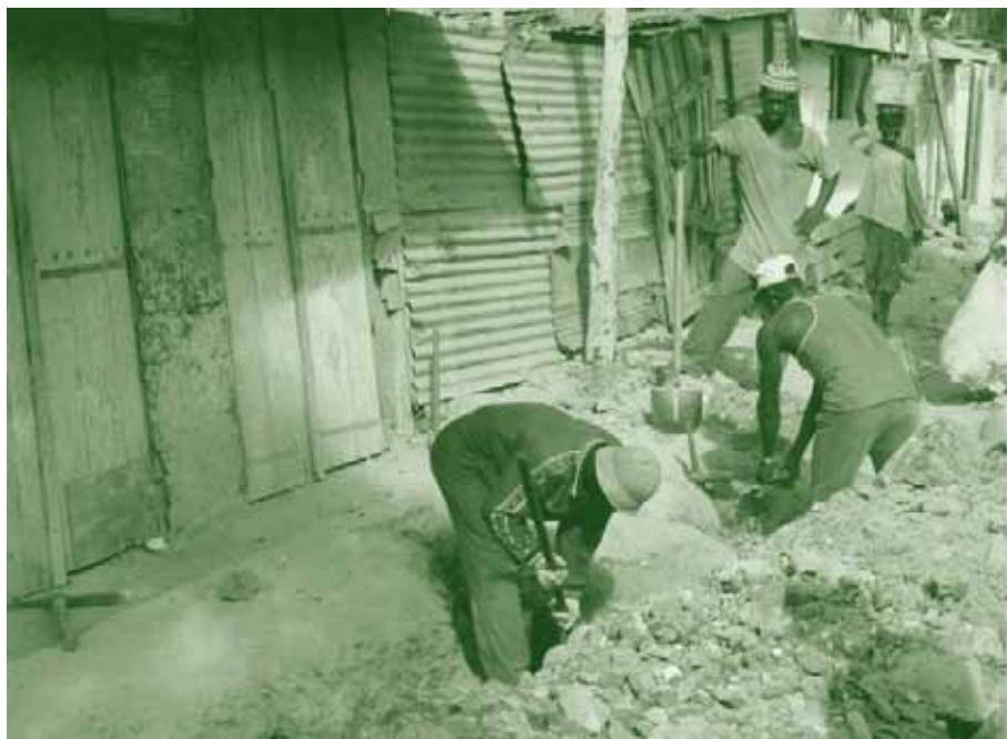
Fouille à Baraka (Dakar, Sénégal) en vue de la pose des canalisations à petit diamètre
