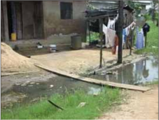
Le quartier de Mambanda, Douala IV : eaux stagnantes autour des habitations
