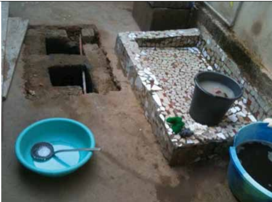
Système de dégraissage à Songrande à Ouagadougou
