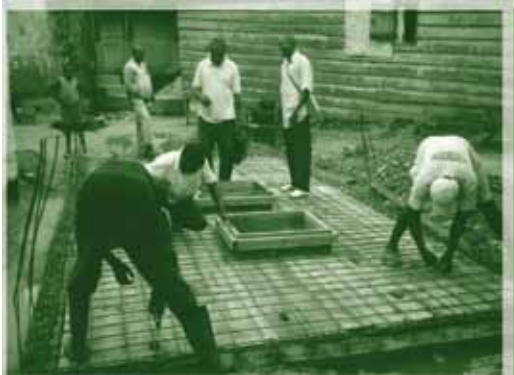
Chantiers de construction d'une fosse septique et du filtre sous gravier nu à Douala au Cameroun
