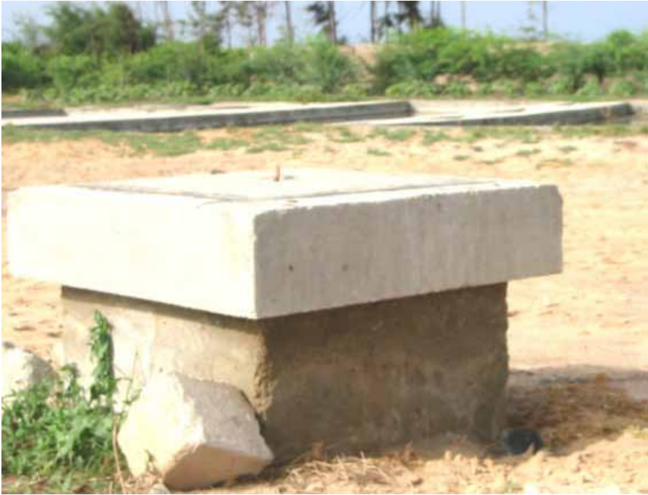
Figure 13.17 : Surélévation d'un regard de visite pour compenser la faible profondeur de pose.
