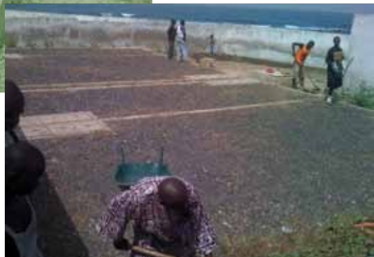
Bassin de lagunage en fonction
