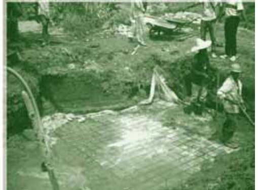
Chantiers de construction d'une fosse septique et du filtre sous gravier nu à Douala au Cameroun
