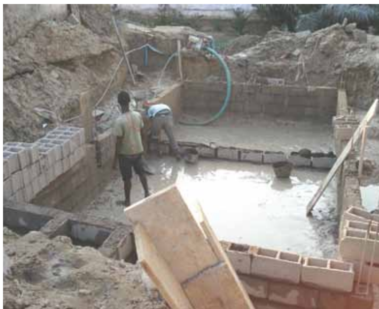
2 ème station d'épuration en construction à Tractafic (Douala II).
