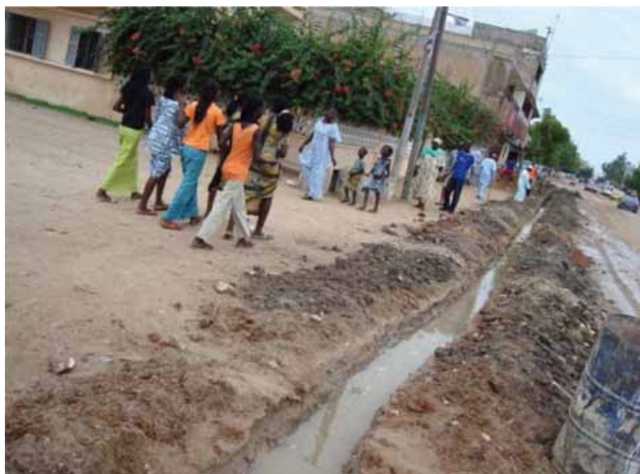
Construction du réseau d'évacuation des eaux usées
