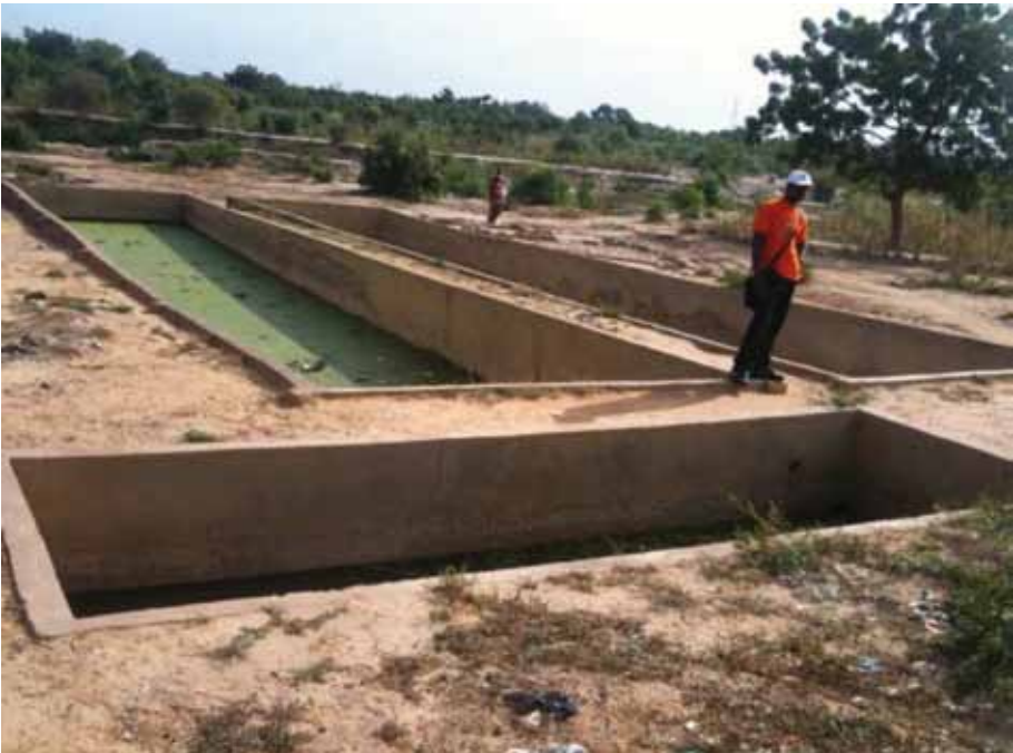
Station de lagunage de Nongr Masson à Ouagadougou
